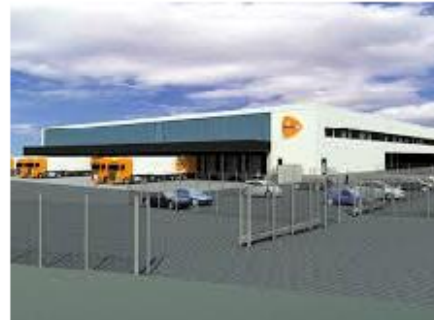
PostPakket distributiecentra Zeer content met Ruigrok's onderhouds- en servicedienst
