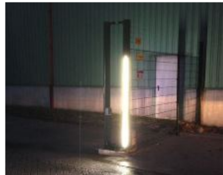
LED balk bij schuifpoort Betere zichtbaarheid = minder kans op aanrijding
